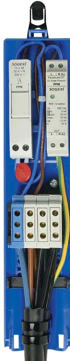
Bornier BD3 2 à 4 x 3 entrées 16 mm 2 L 43 mm
