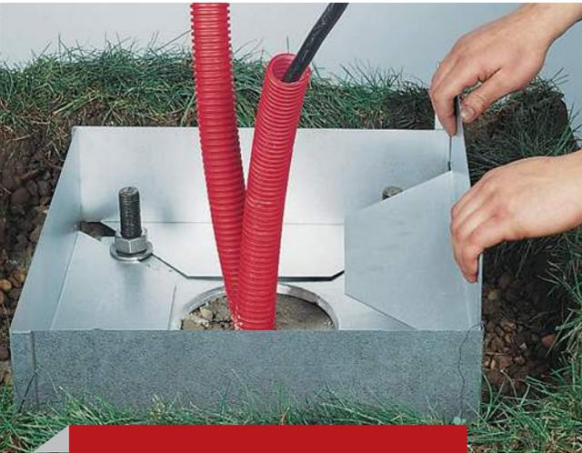
Réserve l'emplacement pour la semelle d'un candélabre qui ne sera implanté sur le massif qu'après la finition du revêtement de sol.
